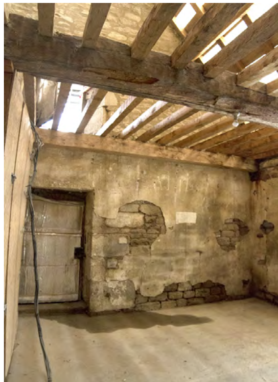
La sacristie pendant les travaux.
