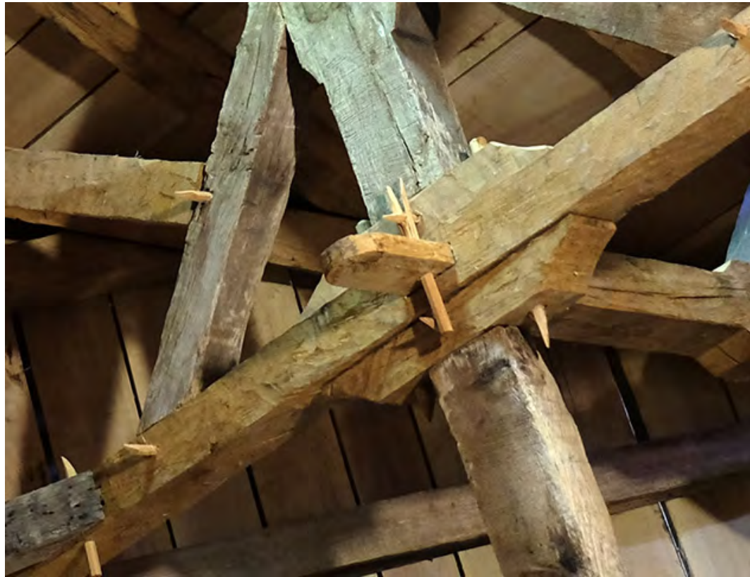
Aperçu du travail de restauration avec reprise d'anciens éléments de charpente
