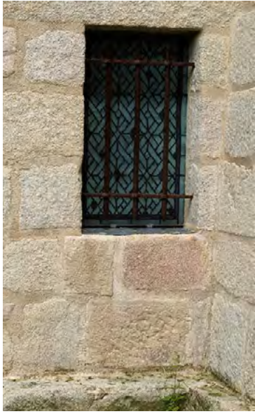
La baie, très basse, est une ancienne porte.
