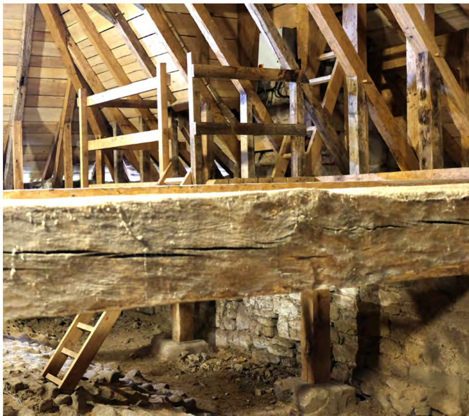
L'accès à la passerelle de visite des cloches
