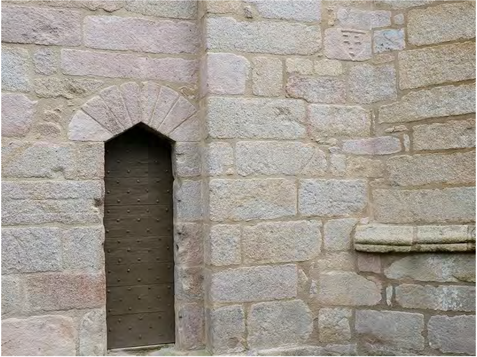
Cette porte romane est l'accès des catéchumènes
