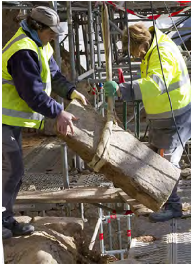
Démontage du contrefort sud
