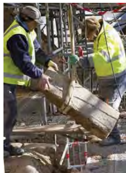
Démontage du contrefort sud
