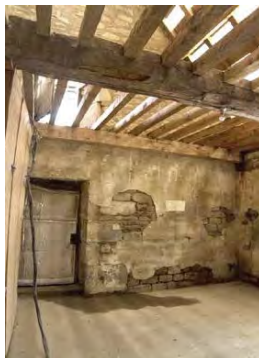
La sacristie pendant les travaux.
